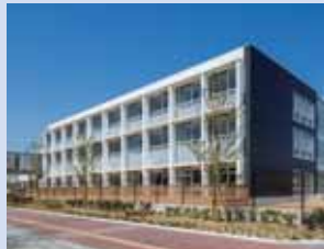
福岡市立照葉北小学校
