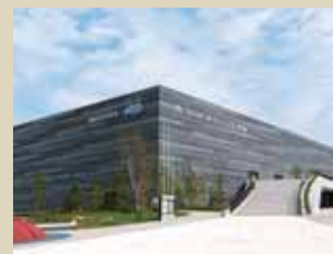
福岡市総合体育館
