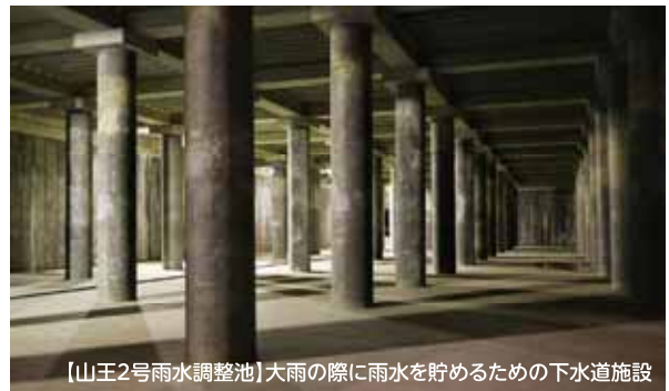
【中部2号幹線】雨水を海に流すための下水道施設
