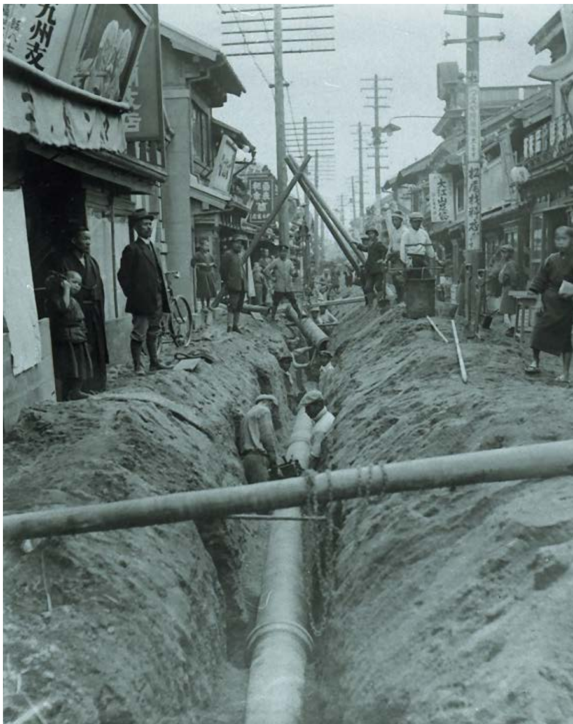
昭和6年頃の配水管の布設工事（現在の博多区下川端町～綱場町付近）
