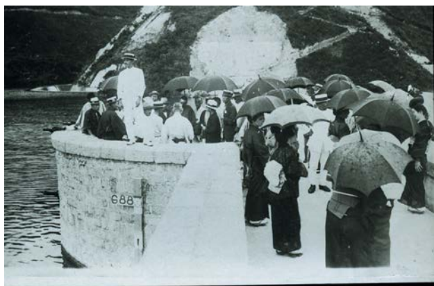
曲渕ダム堰堤上で完成を祝う人々 (昭和 6~9 年)
