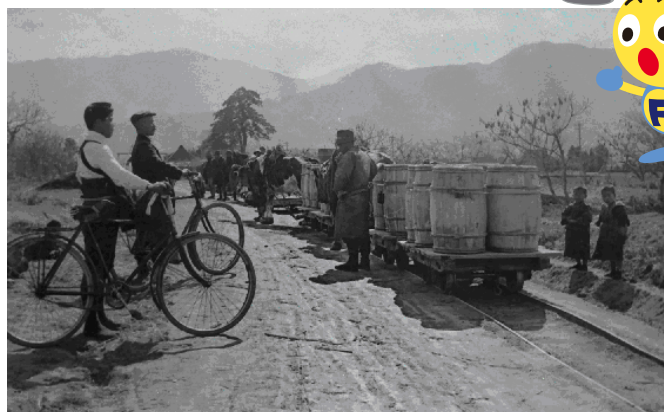
曲渕ダムの拡張工事現場へは鉄管やセメント等をトラックに載せて牛馬に引かせて運んだ (昭和 6~9 年)
