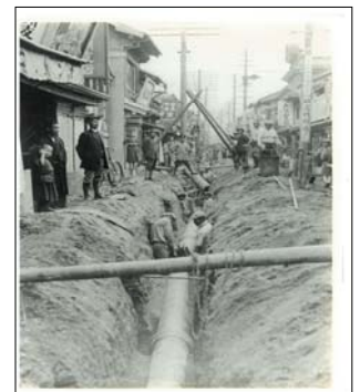
配水管工事の様子
