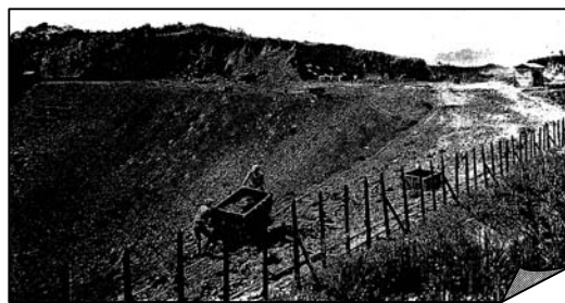
ろ過池工事の様子
