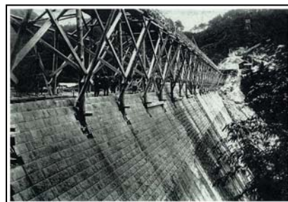
拡張工事の様子
