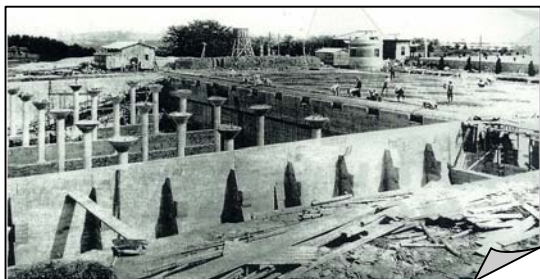
配水池工事の様子
