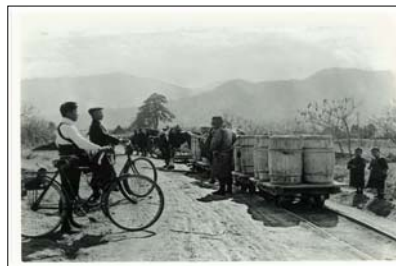
建設現場へ材料を 運搬する様子
