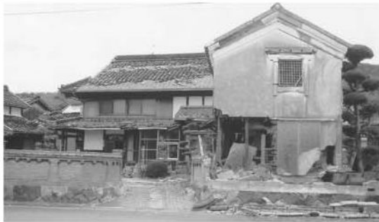
地域のつながり 地震により影響 西浦今津から海沿いのた住宅の数が視界に入道を北へ向かい、西浦地区に広がります。互が寄り添った
