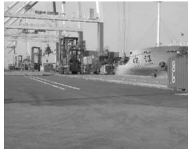
ヤード復旧状況 (平成18年10月香椎P P地区)
