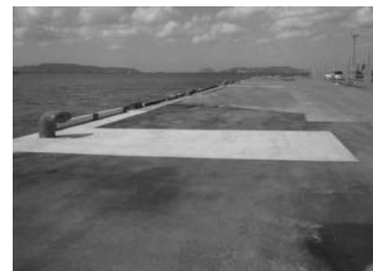
係船柱基礎の復旧状況 (平成18年2月)
