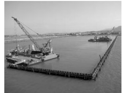
埋立流出土砂の泊地等への流れ込み防止を目的とした土留矢板の施工状況 (平成18年3月)
