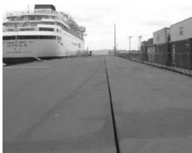
エプロンの破損・沈下により段差が発生 (平成17年3月)
