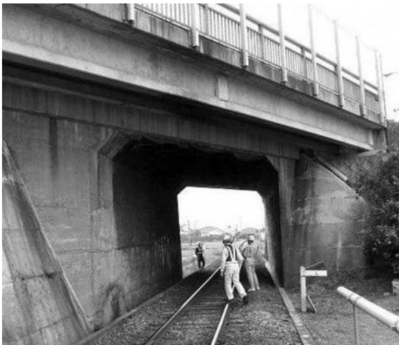
道路構造物の点検
