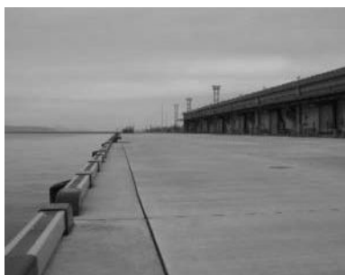
エプロンの復旧状況 （平成18年12月 岸壁-10m）
