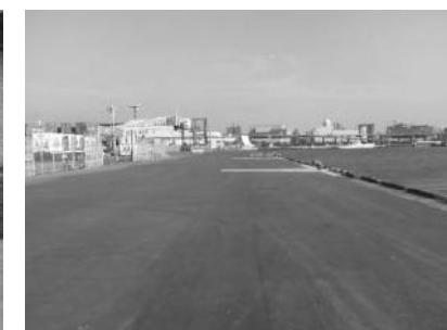
エプロンの復旧状況 (平成18年7月)
