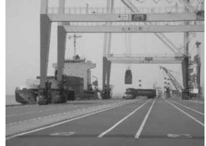
ヤードの復旧状況 (平成18年8月 I C地区)
