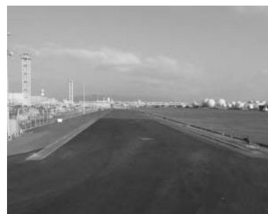
エプロンの復旧状況 （平成18年9月 岸壁-12m）
