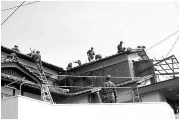
余震の中でのビニールシート・漁網の展張作業
