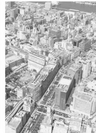
建築物の耐震化は震災対策の基本といえます
