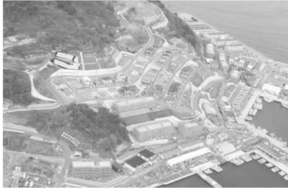
現在の工事状況（平成19年12月26日撮影）
