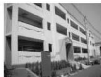
完成した市営住宅
