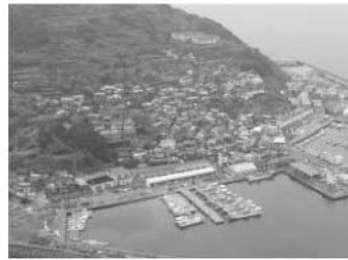
【写真上】復興事業完了後の玄界島 (平成 20 年 3 月 25 日撮影)
