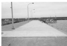
奈多漁港(係留施設)
