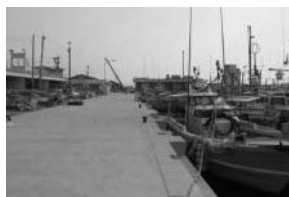
玄界島漁港(係留施設)
