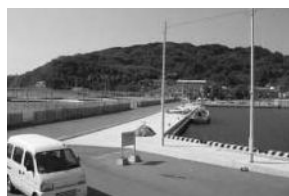
志賀島漁港(係留施設)
