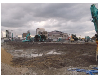
(外構・整地工事中)
