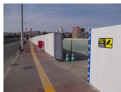
(解体後：パネル設置)
