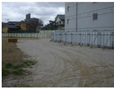
②解体・整地工事後
