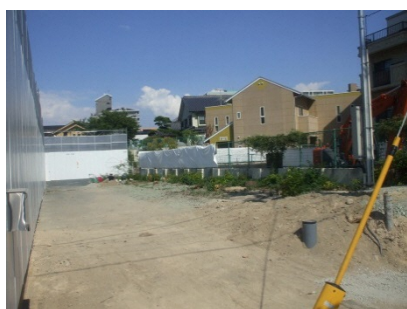
①建物解体前
