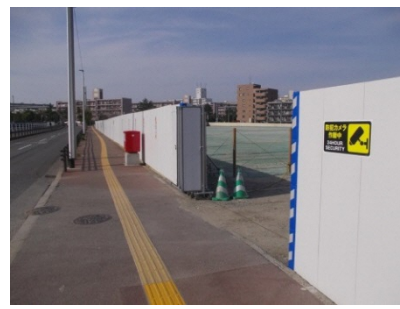
③パネル設置状況
