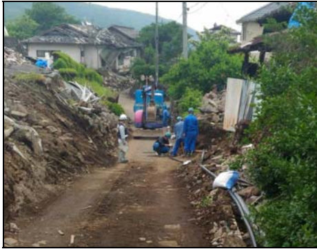
写真-3-3 西原村での応急復旧
