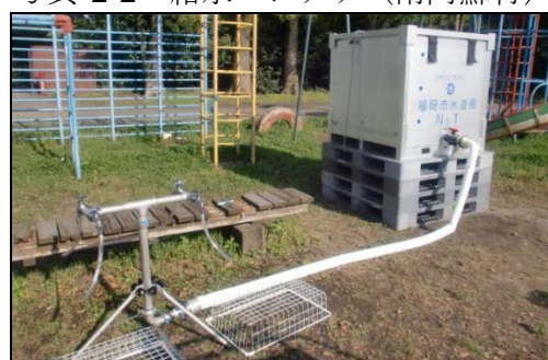
写真-2-2 給水コンテナ (南阿蘇村)
