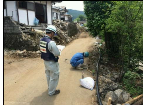
写真-3-4 西原村での応急復旧
