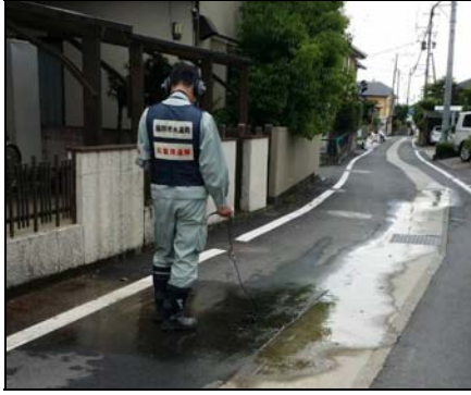
写真-3-1 熊本市での漏水調査
