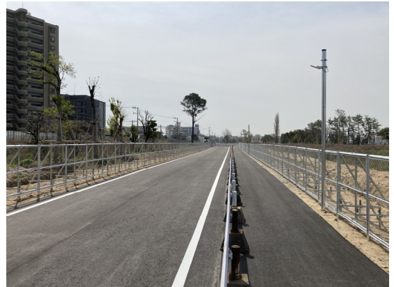
③ 仮設道路
