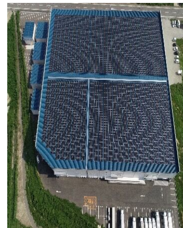
玄望園営業所に設置している太陽光パネル
