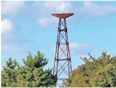
ロープウェイの支柱跡
