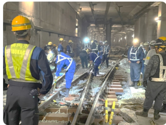
(参考) 夜間工事 (分岐器更新工事)
