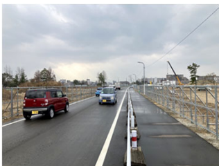
【北エリア】仮設道路の供用
