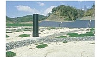
遮水シート・保護砂・ガス抜き
