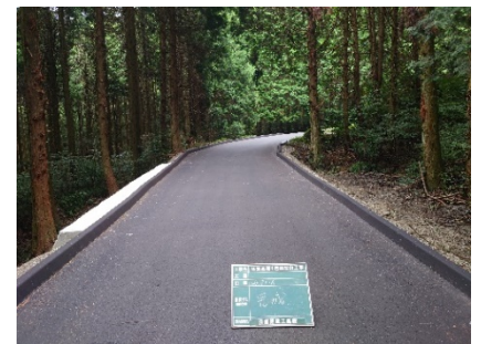
【既存林道の施設補強工事】
