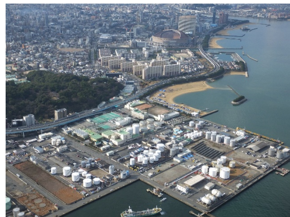
水処理センター（下水処理場）
