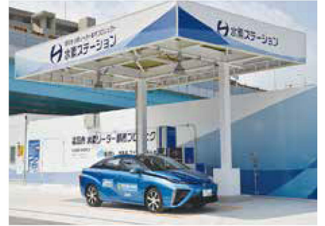
▲水素ステーション(福岡市)
