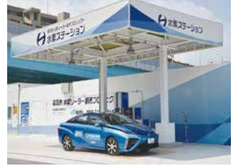
▲水素ステーション(福岡市)
