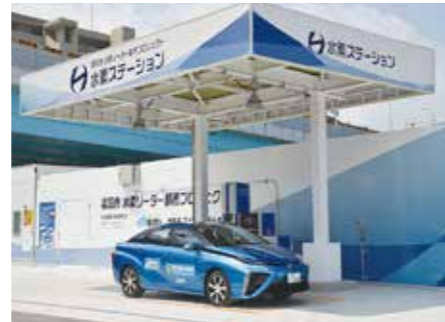
▲水素ステーション(福岡市)
