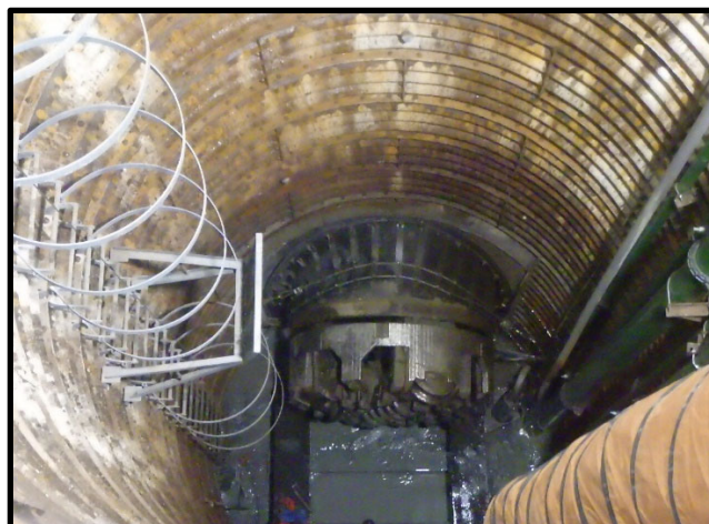
④ 中間立坑内（深さ 8.5m）
