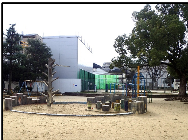
④ 中間立坑（防音ハウス）福海公園内
