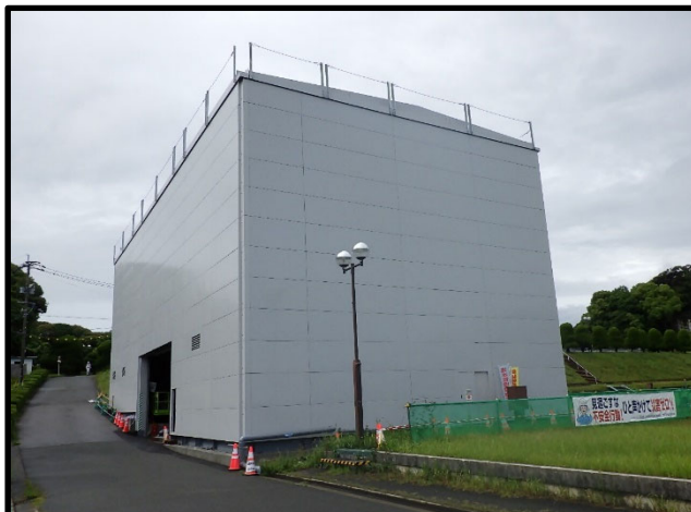
① 発進立坑（防音ハウス）高宮浄水場内
