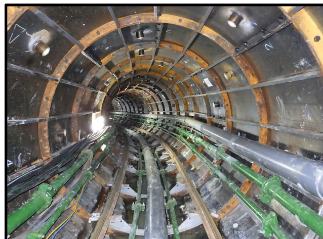
③ セグメント設置（内径 1350 mm）
