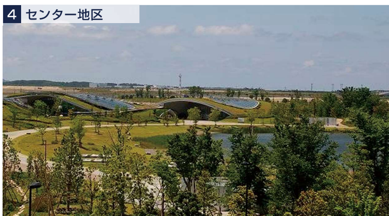
アイランドシティ中央公園よりセンター地区を望む
