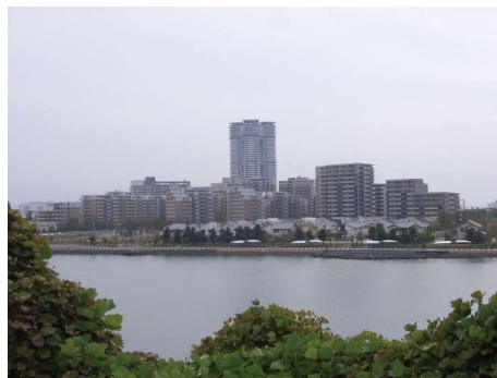
多くの人が海を見ることができるまちとなるように、建物の高さ・配置が工夫されています。
