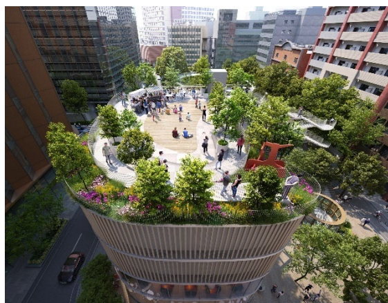
公募対象公園施設 屋上広場「空のにわ」
