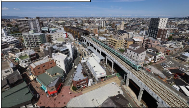
雑餉隈高架駅と高架橋
