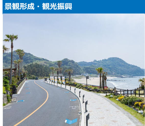
福岡志摩前原線（西区）
