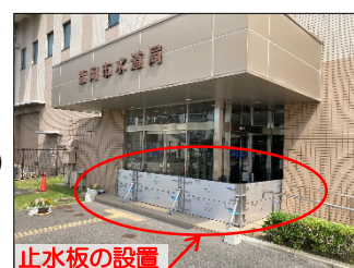
止水板の設置 水道局本庁舎(別館)の耐水化
