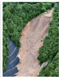
廃棄された土砂の崩落により 死者1名、重傷者1名 住宅被害1棟
