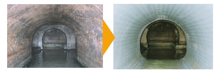
下水道管の長寿命化
