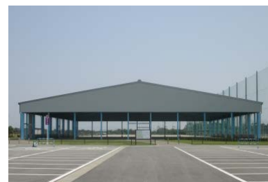
【雁ノ巣レクリエーションセンター】全天候型グランド整備
