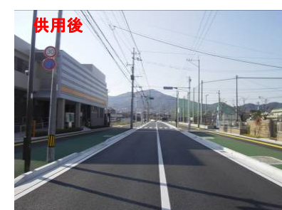
(2)戸切通線(戸切工区)
