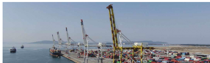
■国際コンテナターミナル
