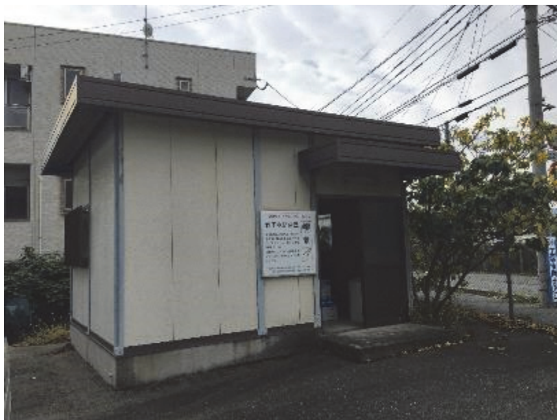
(監査人撮影 竹下水防倉庫－博多区)
