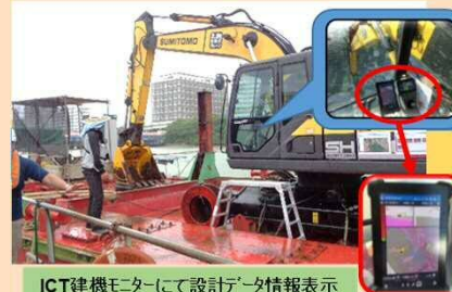
ICT建機モニターにて設計データ情報表示
