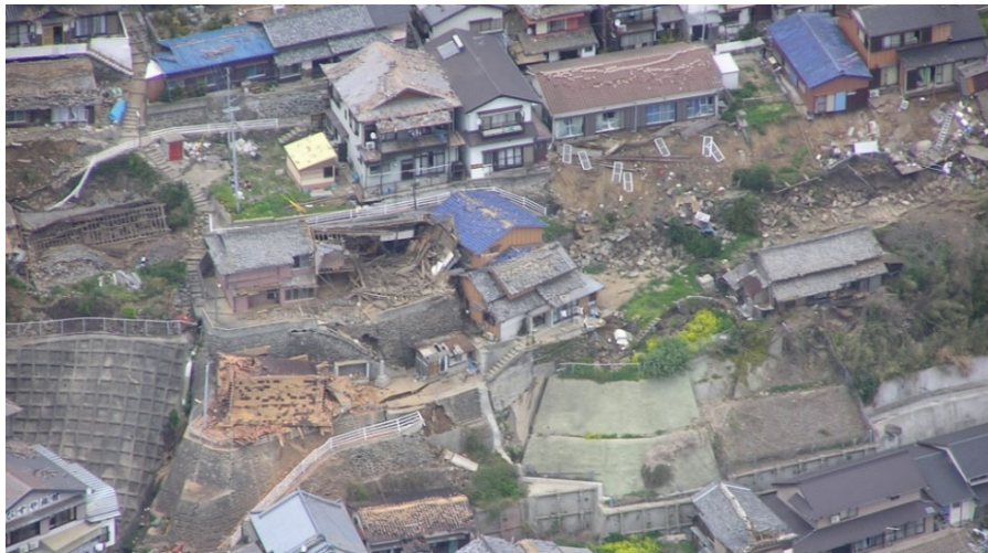
平成17年3月20日福岡県西方沖地震による被害状況（玄界島）
