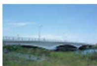
■耐震性に優れた橋（御島かたらい橋）
