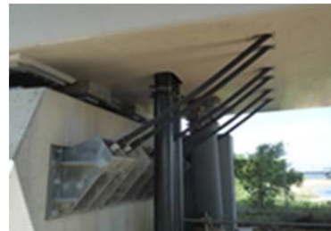
海の中道大橋の落橋防止装置
