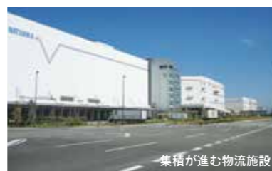
集積が進む物流施設
