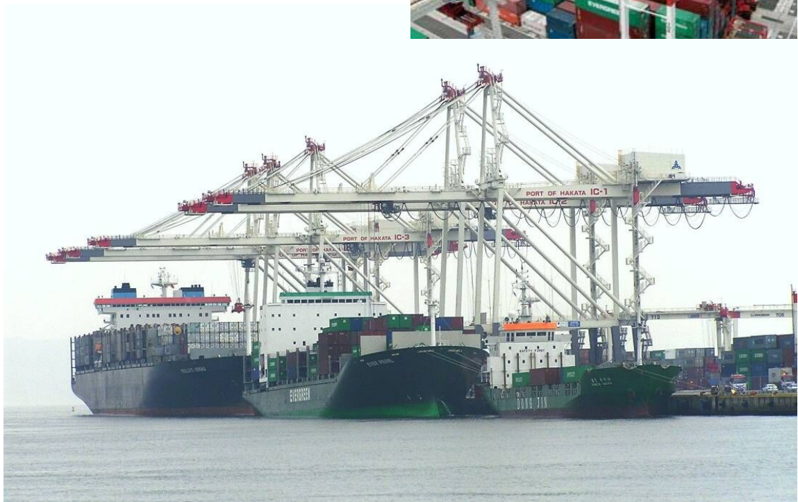
＜稼働中のアイランドシティコンテナターミナル＞
