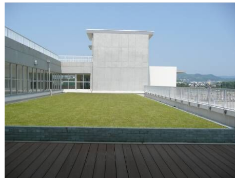
<照葉小中学校の屋上緑化>
