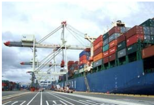
<免震構造を採用したコンテナクレーン>
