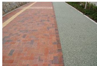
写真 4-2-3 透水性リサイクルレンガや透水性自然石舗装など環境に配慮した素材活用の取組み
