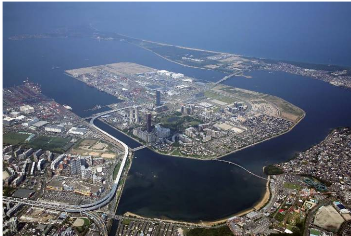
写真2-2-1 アイランドシティの整備状況 (令和2年8月撮影)
