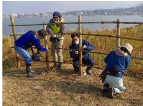
②支柱に竹を結束し、骨組みを作ります。
