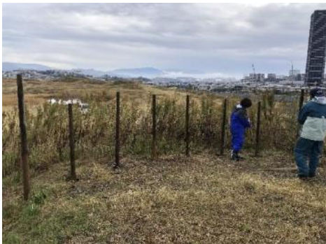
①等間隔に支柱を打ち付けます。
