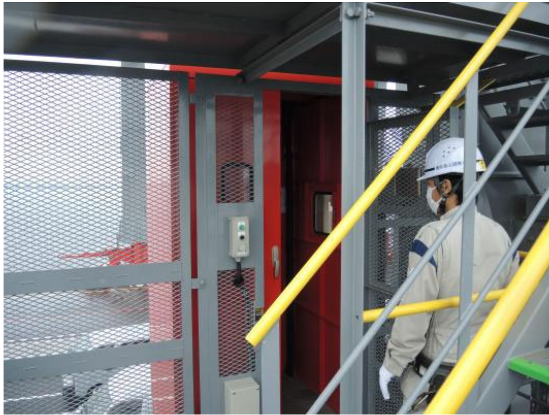
後脚にエレベーターがあります
