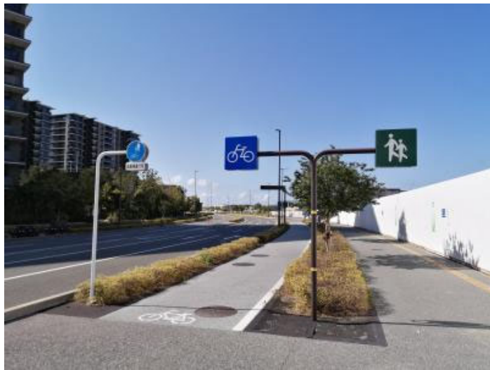
自転車道と歩道をしっかりと区分
