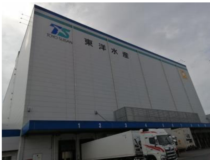
冷蔵倉庫の外観
