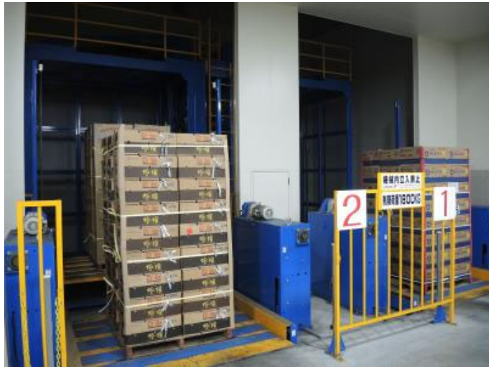
大型のエレベーターで2階に運びます。
