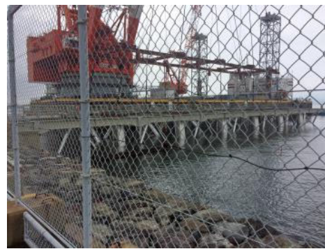
所定の場所に据付けられました。
