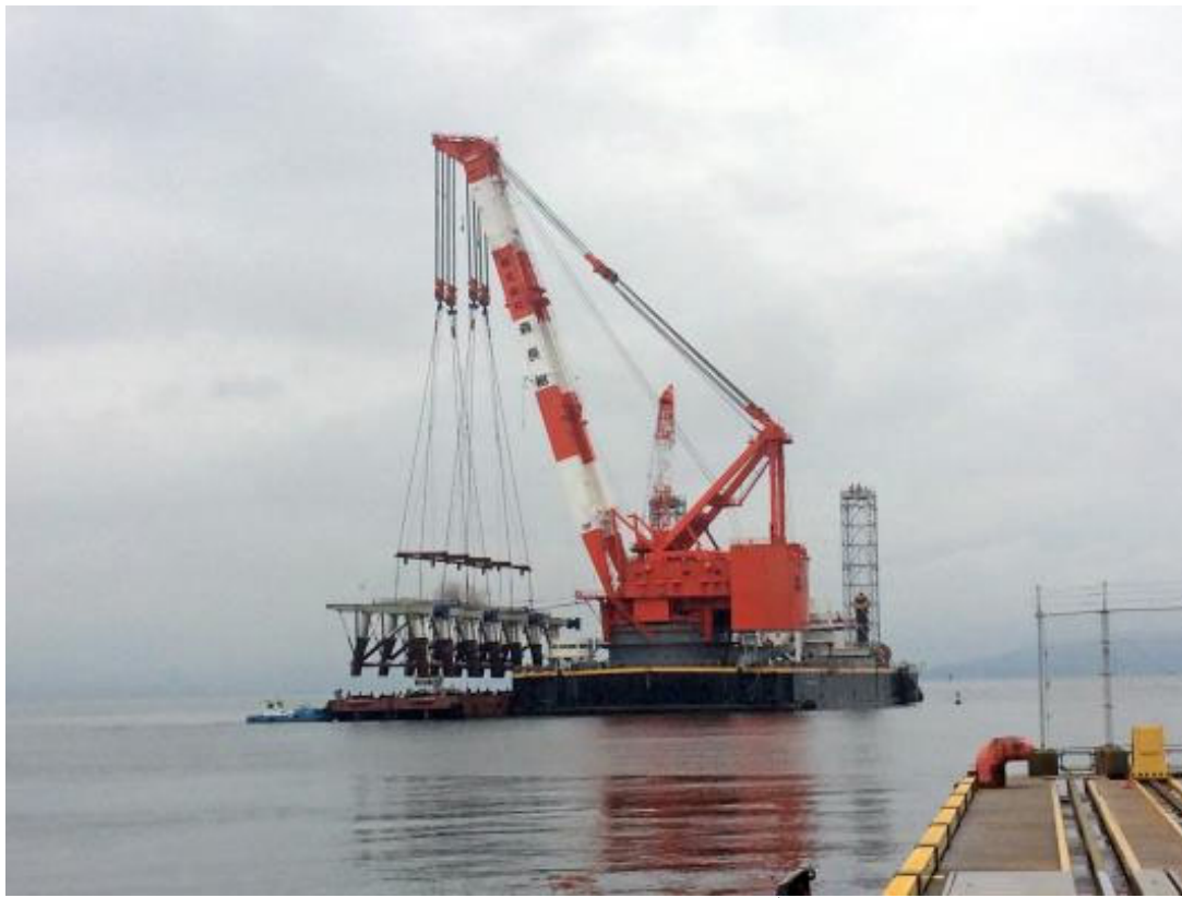
船で運ばれてきたジャケットがクレーンで吊り上げられています。
