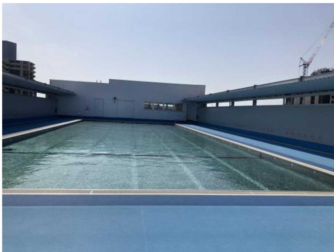
屋上のプール
