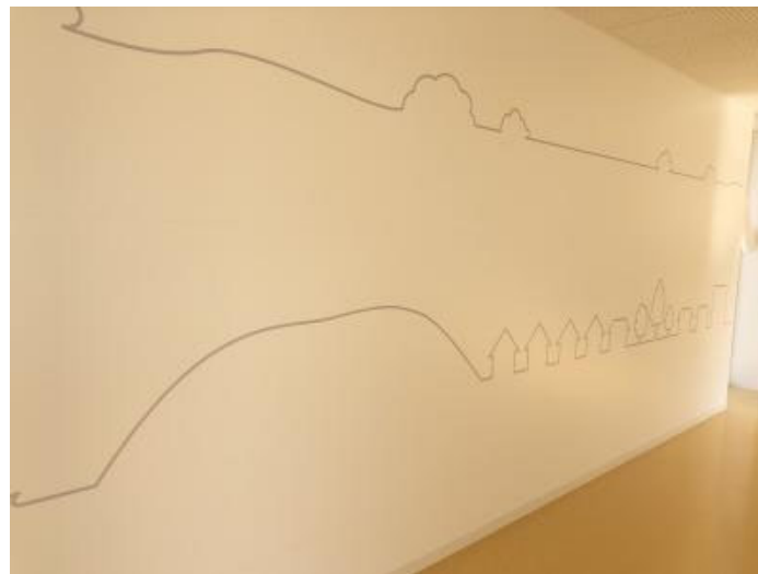
連絡通路の内壁
