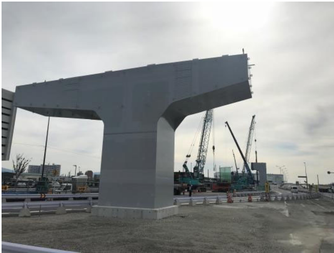
福岡みらい病院横の橋脚
