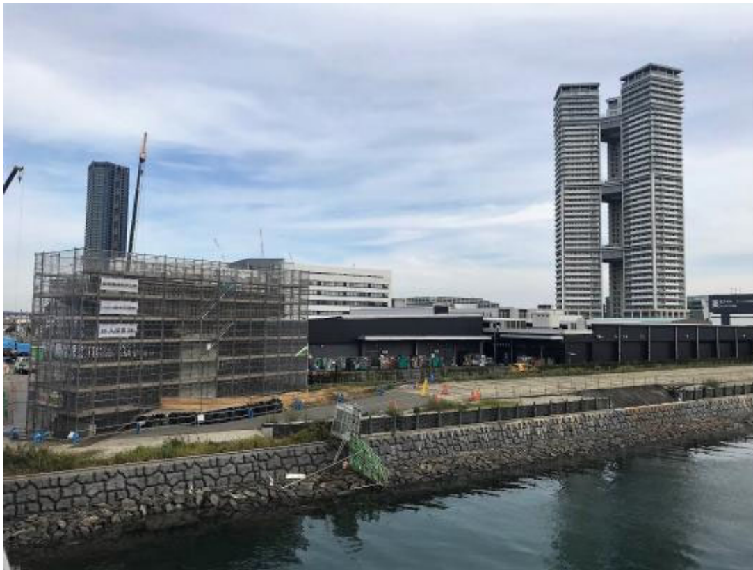
アトレアモール横の橋脚
