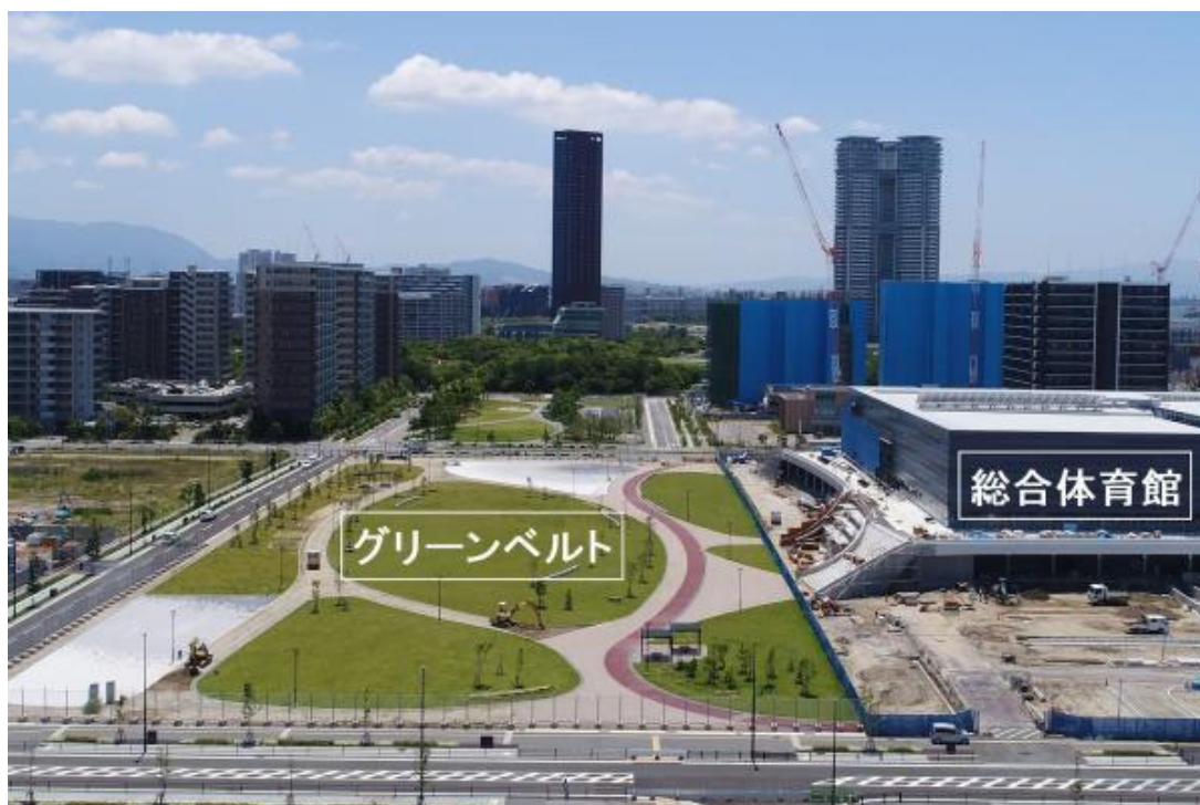
総合体育館に隣接するグリーンベルト（工事中）
