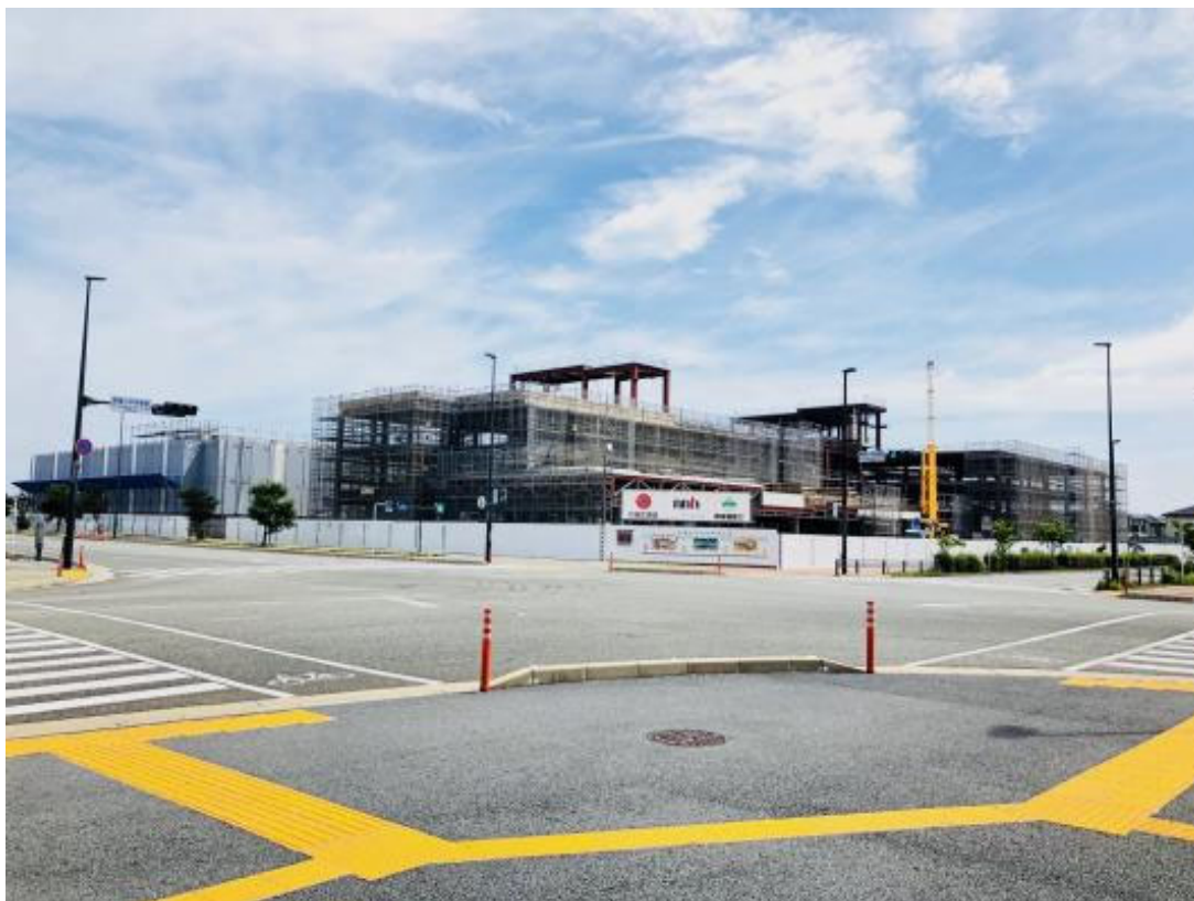
照葉小学校工事現場のようす (7月11日撮影)
