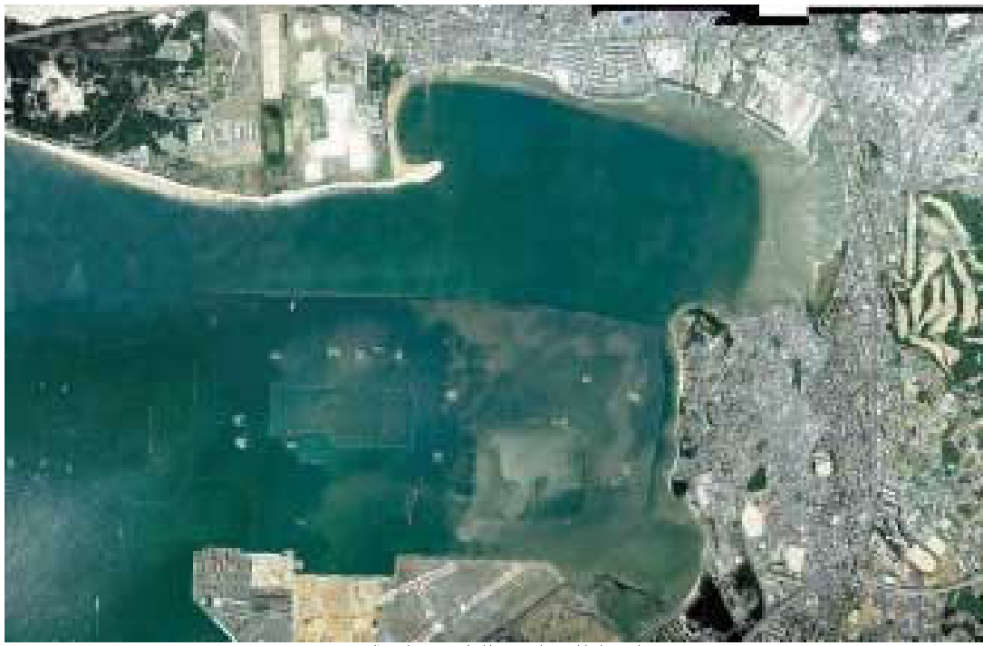
平成6年 工事着工の年の航空写真
