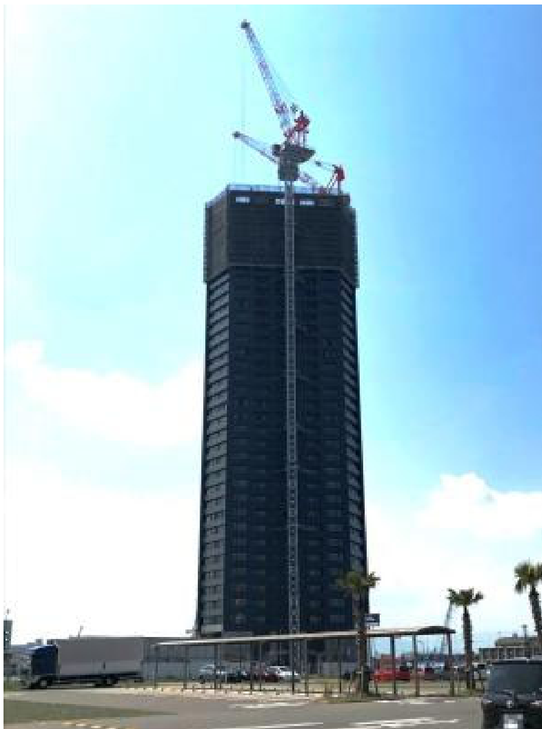
↑建設工事中のセンターマークスタワー（平成30年4月3日撮影）
